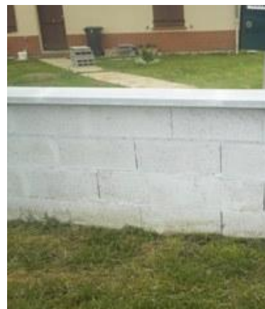
MUR DE CLOTURE NON ENDUIT
